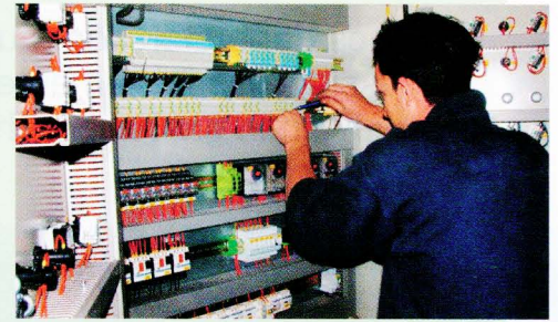
Bei der Nahwärmeversorgung arbeiten in Düsseldorf Energieversorger und Handwerk eng zusammen. Foto: BilderBox
